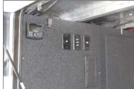
Exterior TV Hookups
