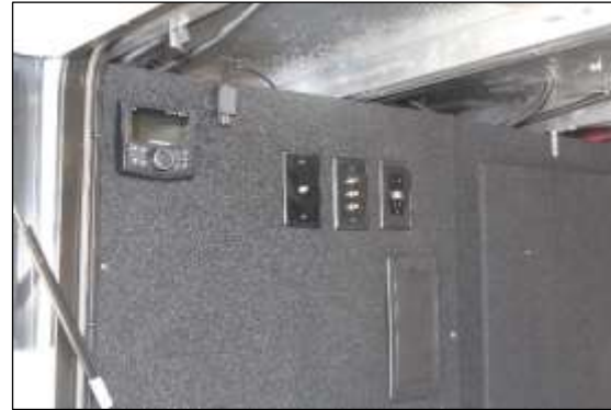
Exterior TV Hookups
